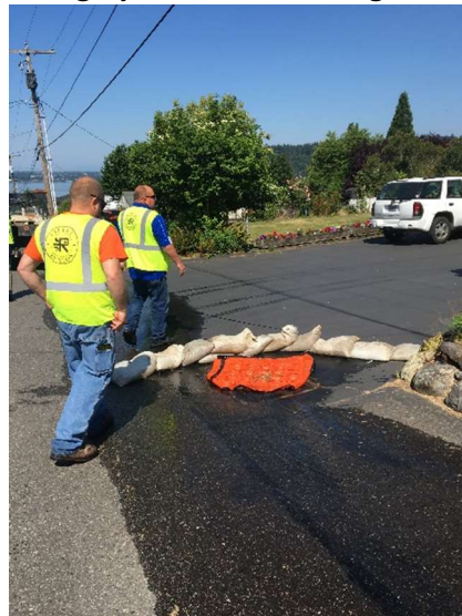
Flowing hydrant F1 discharge control
